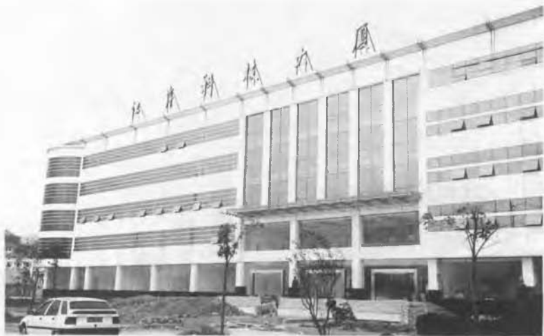
创业中心大楼
