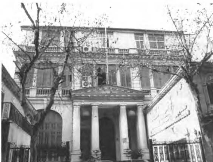
华商总会大楼
